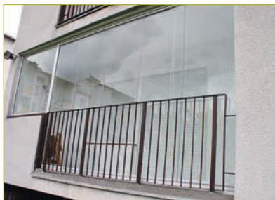
Fot. 5. Jedna z propozycji zabezpieczenia balkonu – oszklenie i krata w niszy
