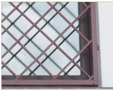
Fot. 4. Prawidłowo zamocowana krata – można było? Tu nożyc nie ma jak włożyć
