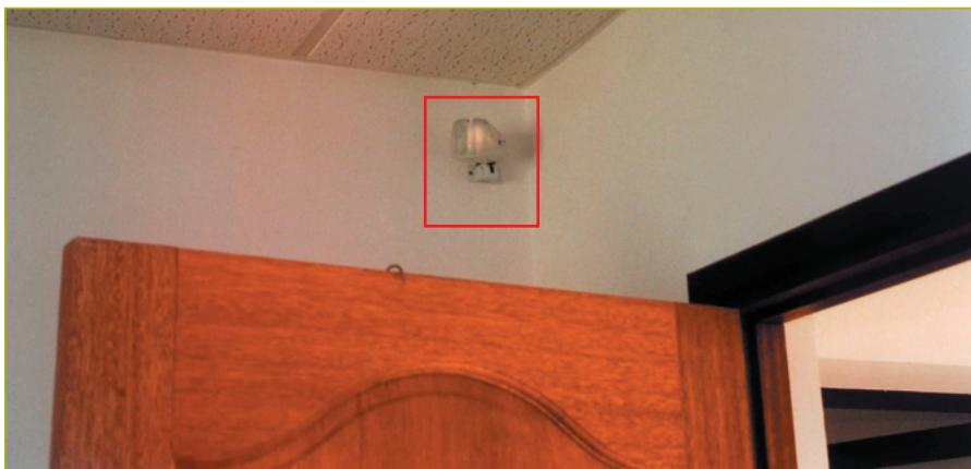
Fot. 1. Typowy błąd – pasywna czujka podczerwieni tuż za drzwiami
