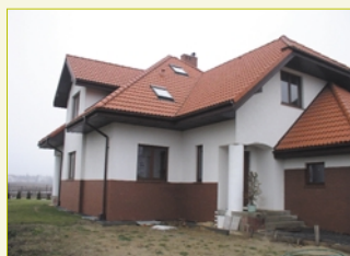
Kamera 2. Pełne pokrycie obserwacji najbardziej istotnego miejsca w budynku – drzwi wejściowych.
